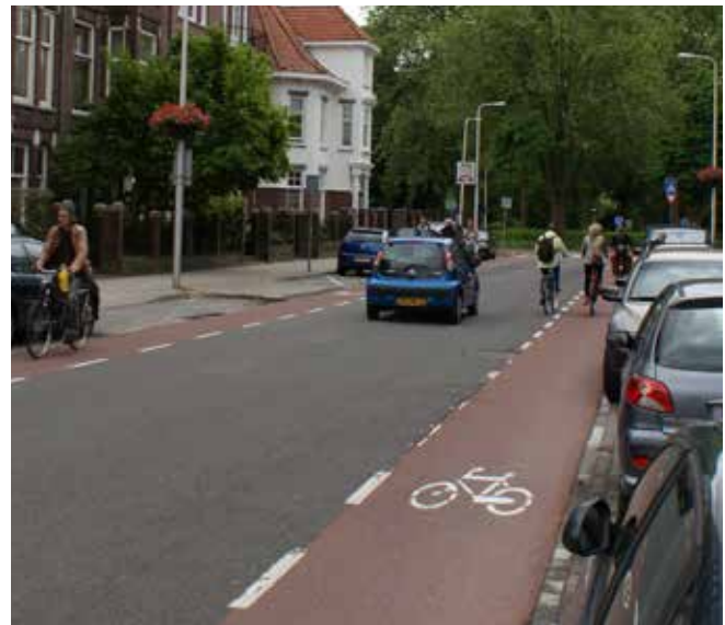
Burgemeester Reigerstraat in Utrecht: the central space is no more than 4.5m wide
